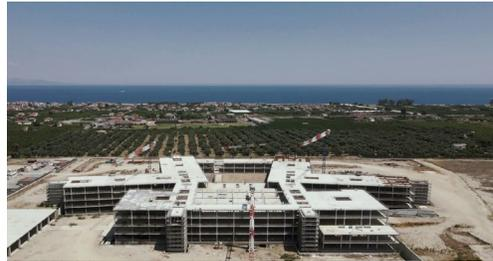
Progettazione della struttura portante con Sistema semi-prefabbricato ed isolatori sismici
